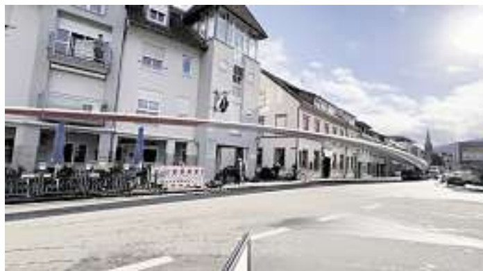
Rotorblatt Höhe Stadtbrücke
