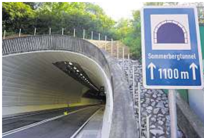
Sommerbergtunnel vor der Freigabe. Foto: Regierungspräsidium Freiburg
