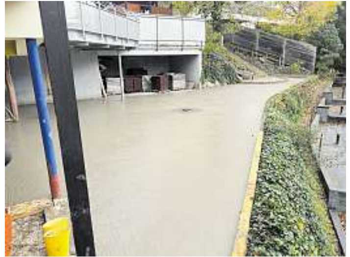
Neu gegossene Bodenplatte...
