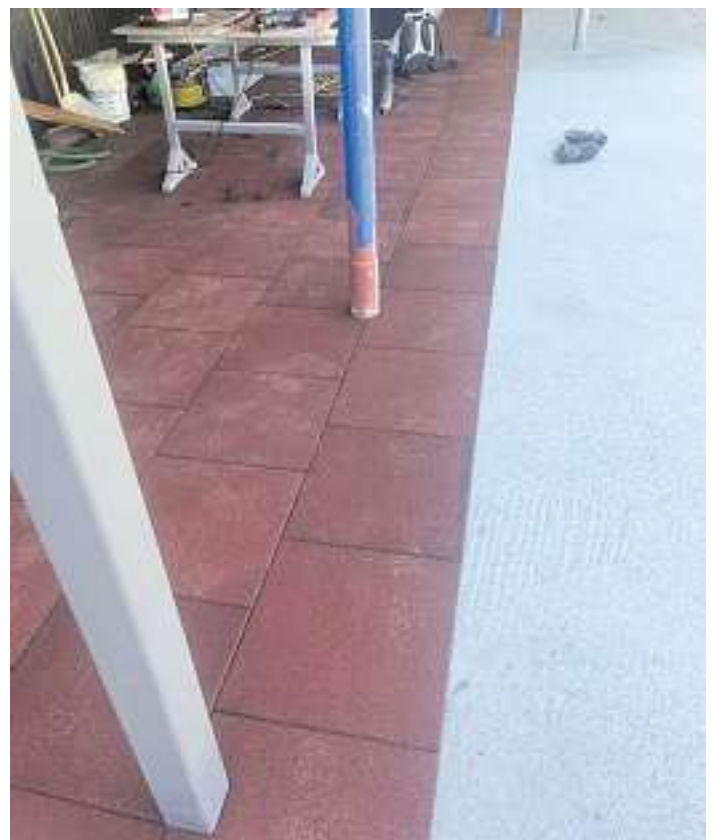
Verlegung der neuen Platten
