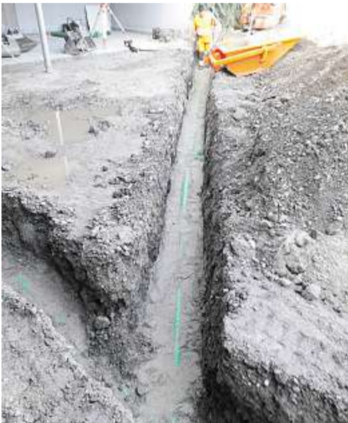
Neuerlegung der Entwässerungsleitungen
