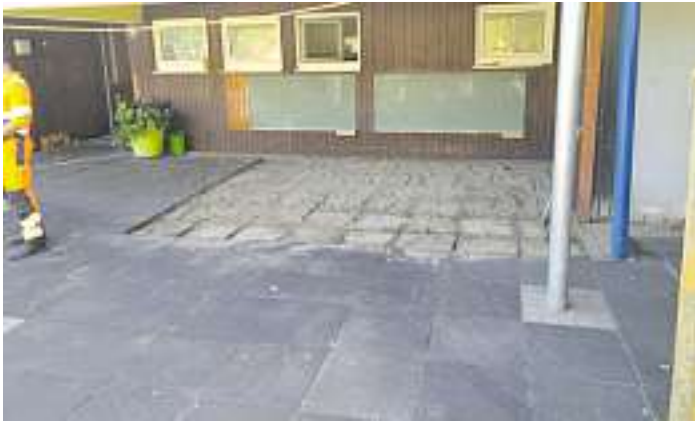
Entsorgung alter Plattenbelag
