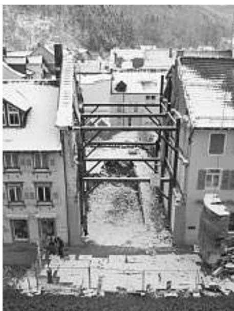
Eine stabile Stahlkonstruktion sichert die Nachbargebäude.
