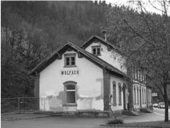
Der alte Bahnhof vor der Sanierung
